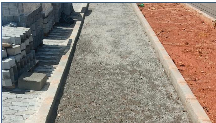
**Passo 2:** O meio-fio pode ser colocado, de modo que fique com 15 cm (altura final que a calçada deve ter), assim ele servirá de fôrma na hora da concretagem.
