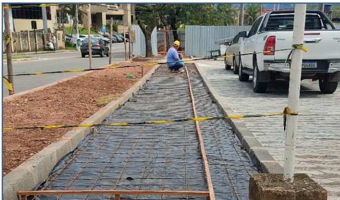
**Passo 5:** Para a concretagem recomenda-se que seja utilizado referencialmente o concreto usinado de 20 MPa. Se sua calçada for pequena, existe a opção de concreto moldado in loco.
